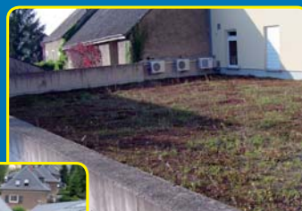
Toit horizontal végétalisé en annexe de la banque Raiffeisen à Redange
