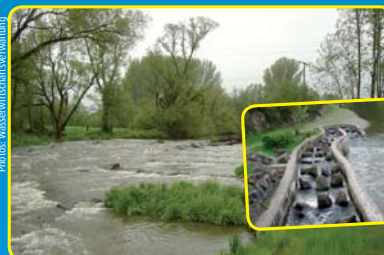
amélioration du passage à poisson à l'aide de rampes à poisson
