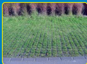
parking perméable à Beckerich
