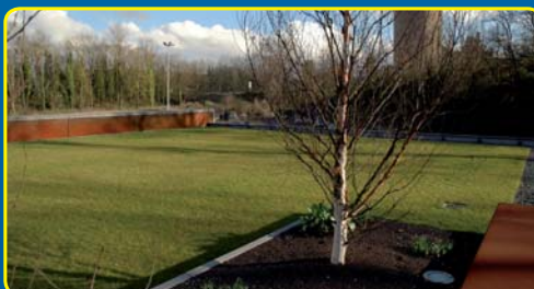
Toit végétalisé à Esch-sur-Alzette
