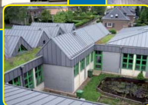
Toit horizontal végétalisé de l'école Nelly Stein à Schiffflange
