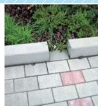
Pavement à joints larges avec déversoir vers un espace vert
