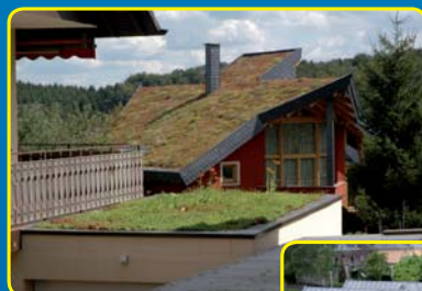
Toit vert incliné à Mitlosheim (D)
